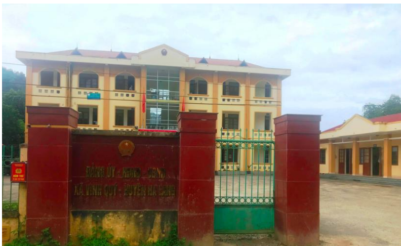
Trụ sở Đảng ủy, HĐND, UBND xã Vinh Quý, huyện Hạ Lang được xây dựng khang trang
