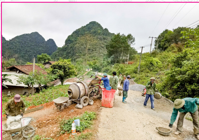
Nhân dân xóm Lũng Hoài đổ bê tông đường giao thông nông thôn năm 2015
