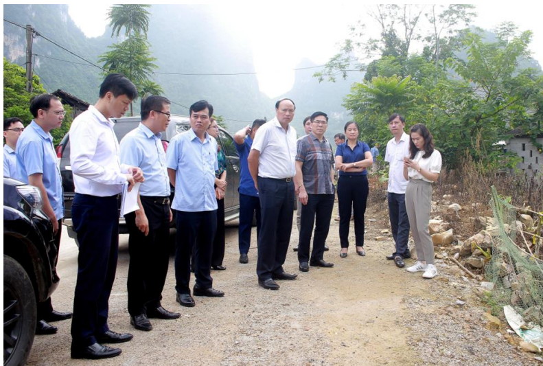
Các thành viên trong Đoàn giám sát HĐND tỉnh, Lãnh đạo UBND huyện Quảng Hòa khảo sát công trình đường nông thôn Tênh Bó - Pò Tẻn, xã Cách Linh, năm 2024.
