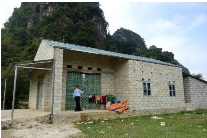
Nhà "Đại đoàn kết" tại xóm Khuổi Luông, xã Cách Linh được nghiệm thu đưa vào sử dụng, năm 2018.
