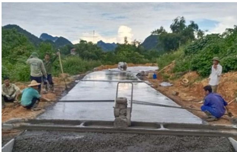
Bê tông hóa đường xóm Nà Chà, xã Mỹ Hưng (Quảng Hòa), tháng 11/2021.
