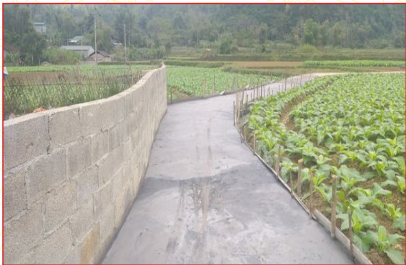
Đường bê tông nội đồng xóm Nà Mừa
