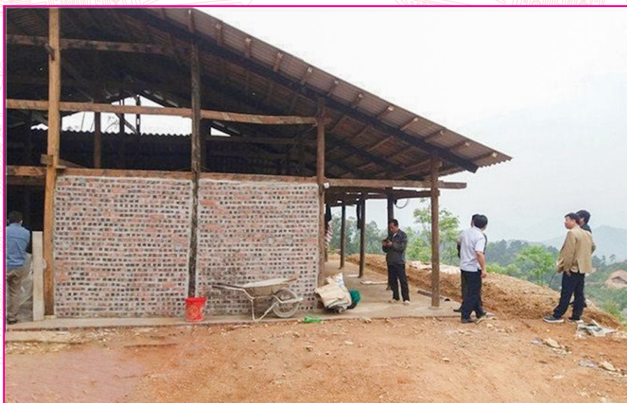
Hộ dân xóm Lũng Lừa, xã Đa Thông được hỗ trợ xây dựng nhà ở từ Đề án xóa nhà tạm, nhà dột nát giai đoạn 2021 - 2025
